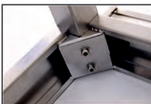
SOLIDNE MOCOWANIE NÓG ZA POMOCĄ DWÓCH ŚRUB
